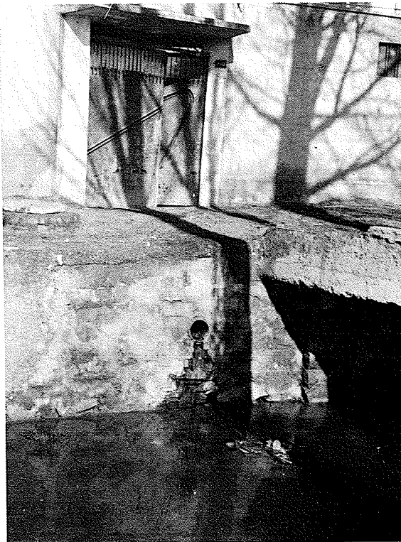
شکل شماره (۴) مجرائی که فاضلاب مشترک را به رودخانه وارد مینماید نشان میدهد
